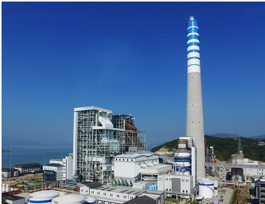
Энергоблок с установленной системой газоочистки завод-изготовитель
