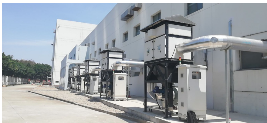
Ряд картриджных пылеуловителей с обвязкой на промышленной площадке
