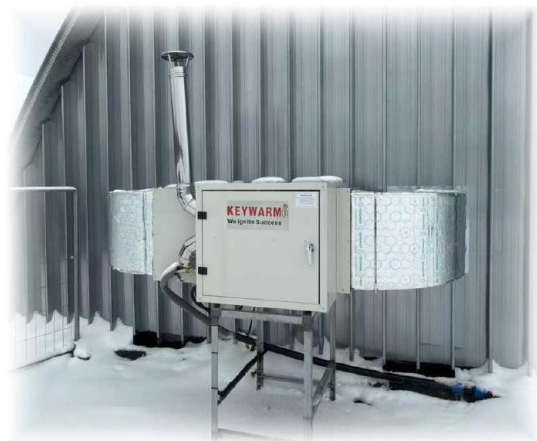
Уличный непрямой воздушонагреватель на объекте с зимой до -30^{\circ}\text{C}
