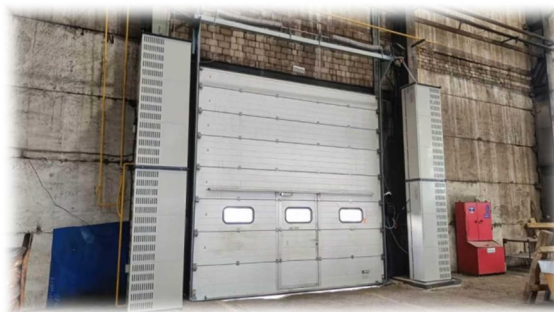
ABL-FM — газовая тепловая завеса на воротах отгрузки
